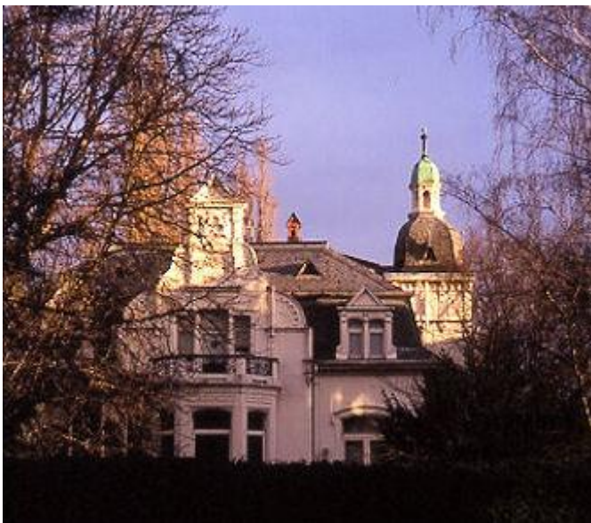
Das herrschaftliche Wohnhaus, das sich Hermann Silberschmidt in der Klütstraße 28 bauen ließ
