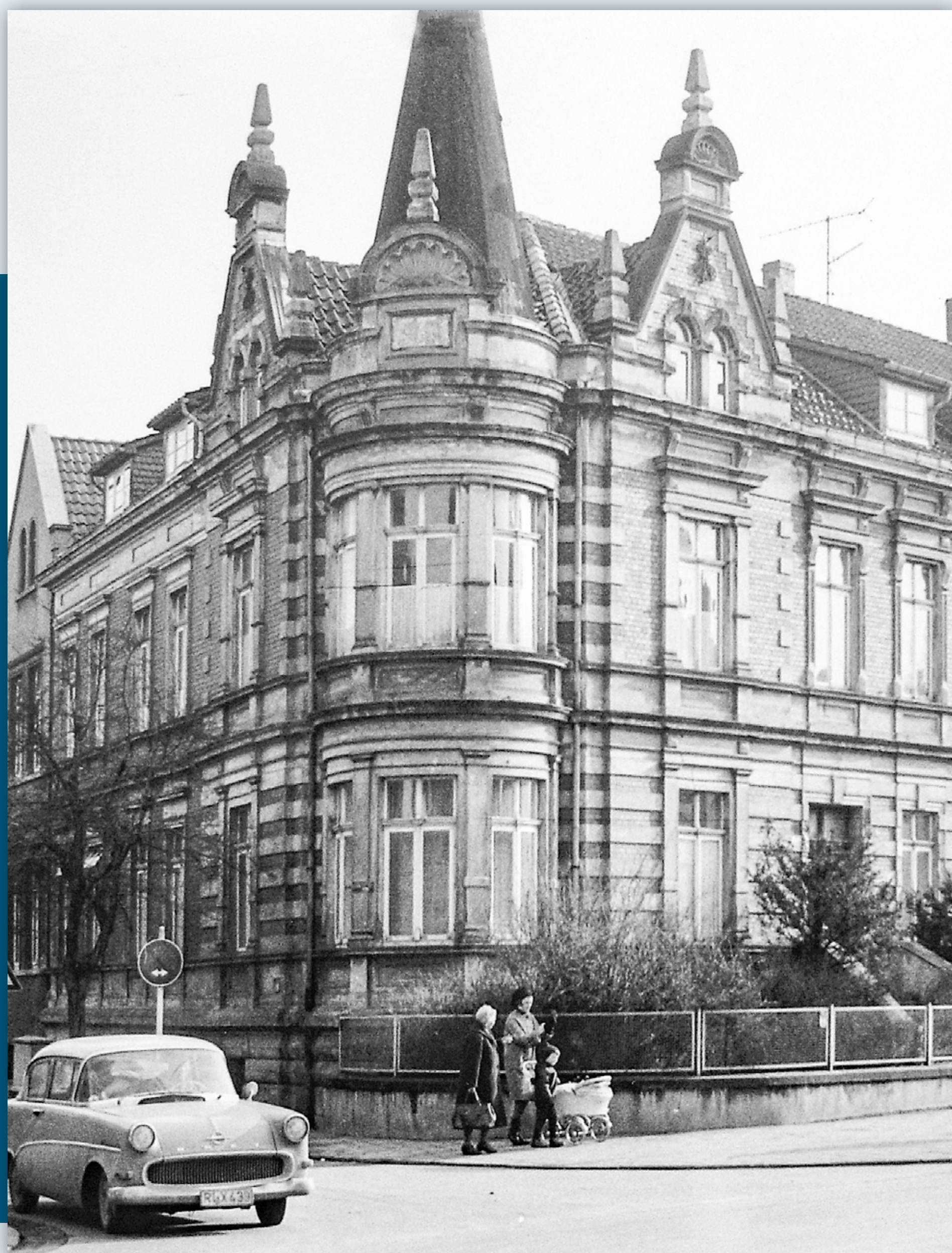
Das 1891 errichtete Haus des Pferdehändlers Salomon Goldstein am Ostertorwall, 1960er Jahre Quelle: Stadt Hameln, Bauaufsichtsamt
